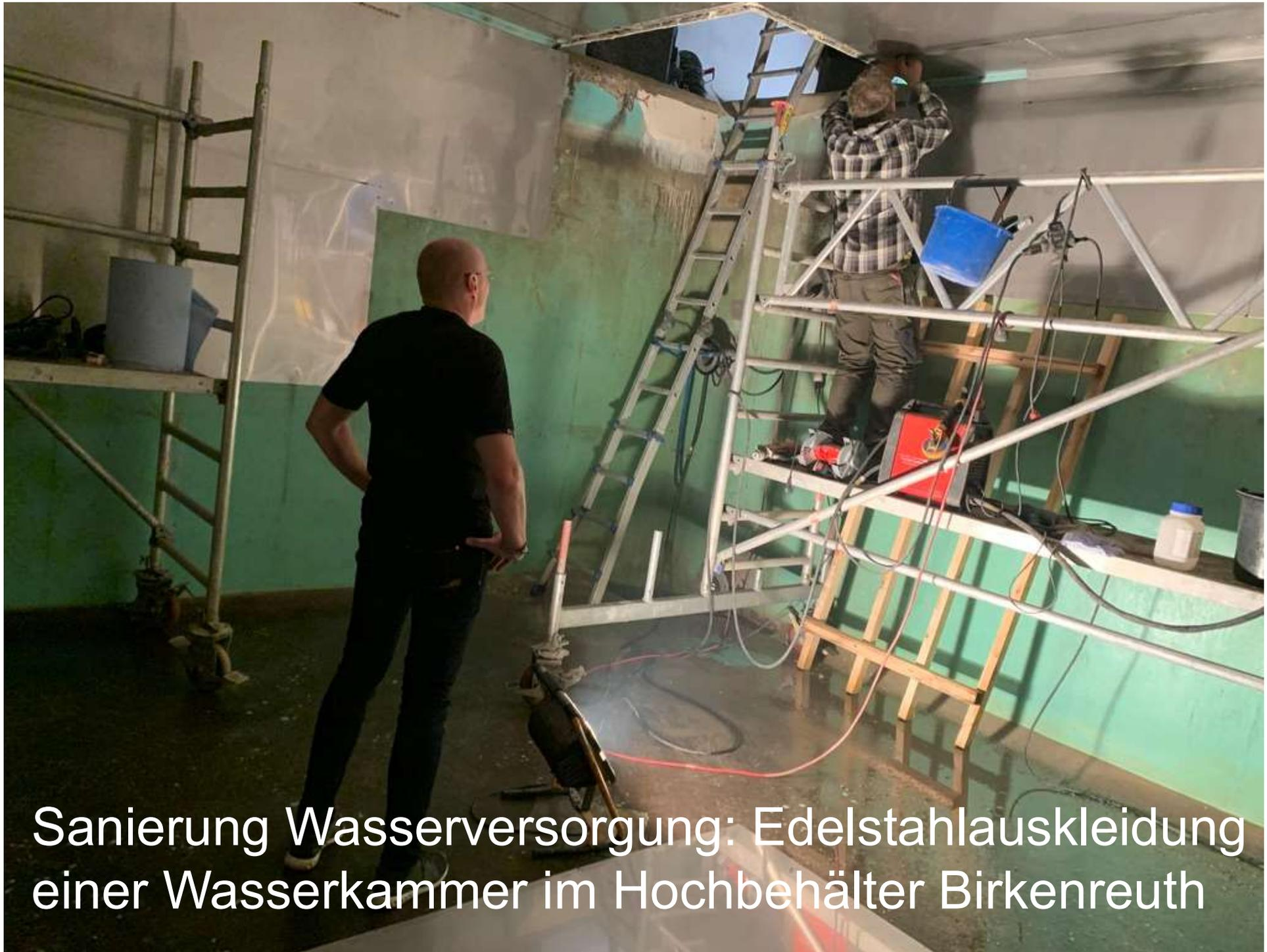
Sanierung Wasserversorgung: Edelstahl auskleidung einer Wasserkammer im Hochbehälter Birkenreuth
