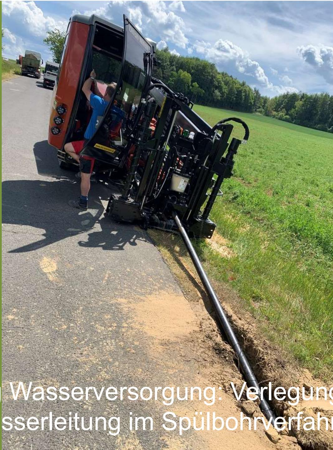
Sanierung Wasserversorgung: Verlegung einer neuen Wasserleitung im Spülbohrverfahren
